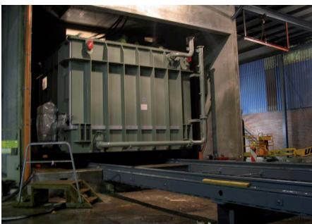
Installation neuer Transformator auf dem Werksgelände von Xstrata
