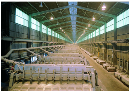
Elektrolysehalle in Hamburg der TRIMET ALUMINIUM AG
