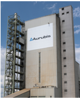
Südsicht des Kayser-Recycling-Systems
