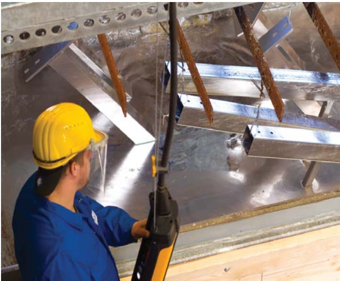
Zentraler Prozessschritt der Feuerverzinkung ist das Eintauchen der Werkstücke in ein Zinkbad.
